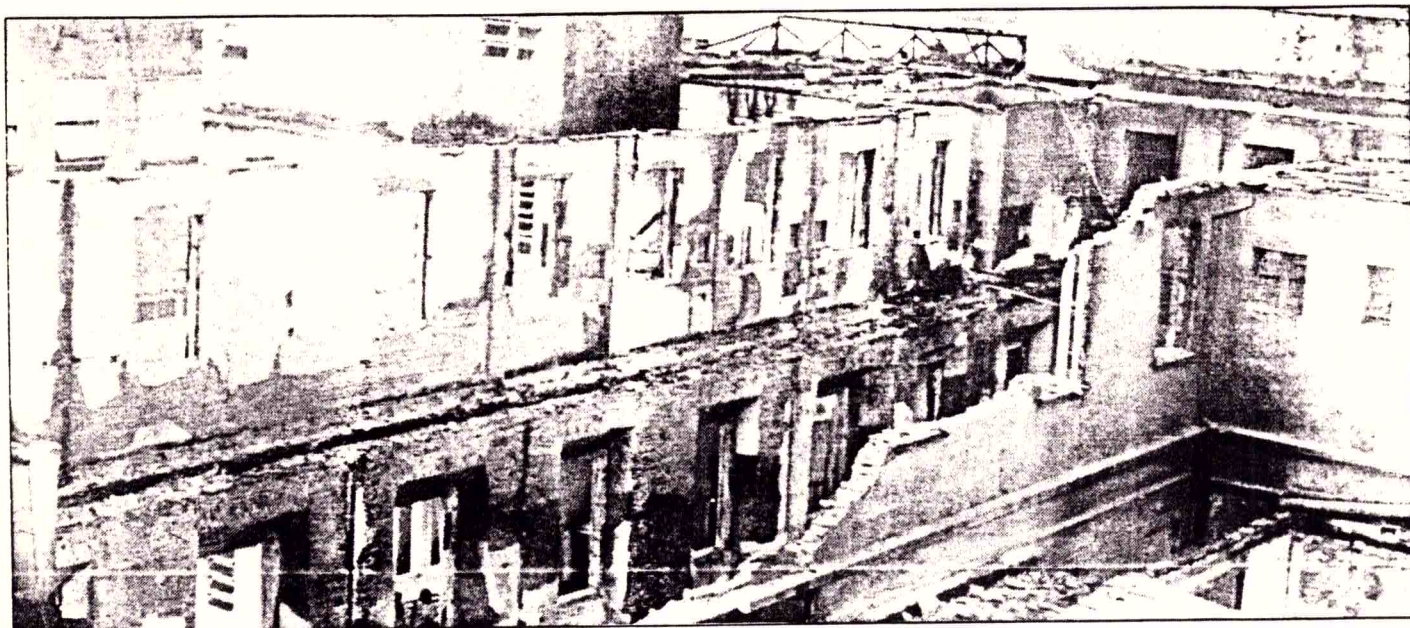
Cenas como esta, do incêndio no Hospital de Caridade em Florianópolis, nos mostram a realidade, nos conduzem a reflexão e recomendam ações efetivas e eficazes.
